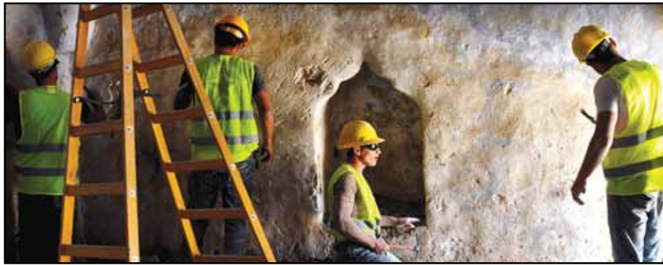
صورة لعمال مشروع مركز المعمار الشعبي (رواق) - كفر اللبد - قلعة البرقاوي
